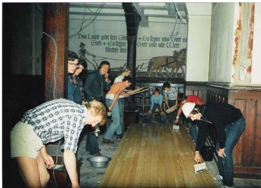
1978/79: Renovierung der Chorräume im Kloster St. Marienberg.
